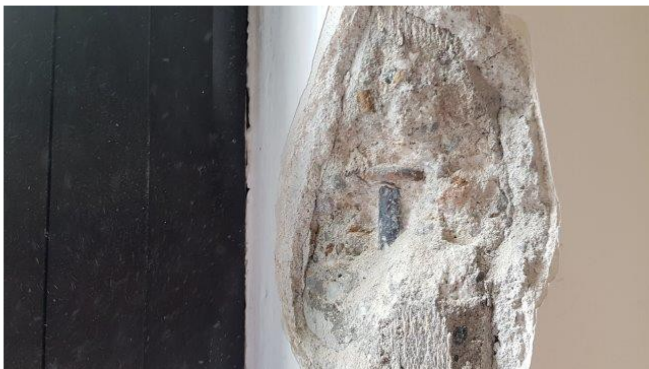
ARMATURE PILASTRI EDIFICIO LATO NORD (PRIMO PIANO)
