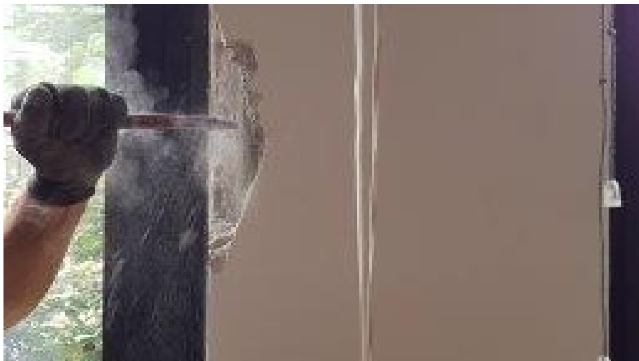
RICERCA ARMATURE PILASTRI FACCIA TA EDIFICIO LATO NORD (PRIMO PIANO)
