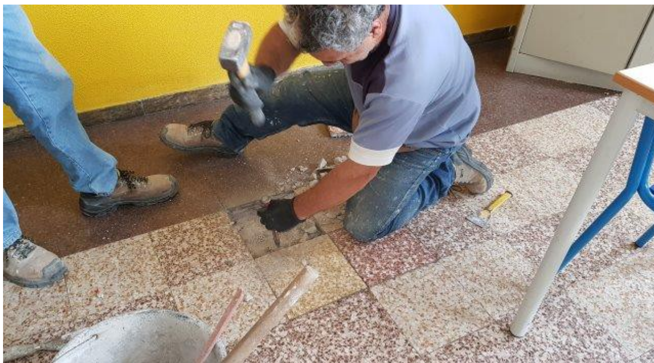
VERIFICA SPESSORE SOLAI CORPO CENTRALE (PRIMO PIANO)
