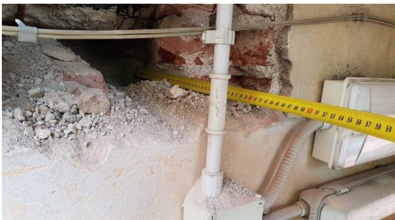
RICERCA CORDOLO SOLAIO (ASSENTE)
