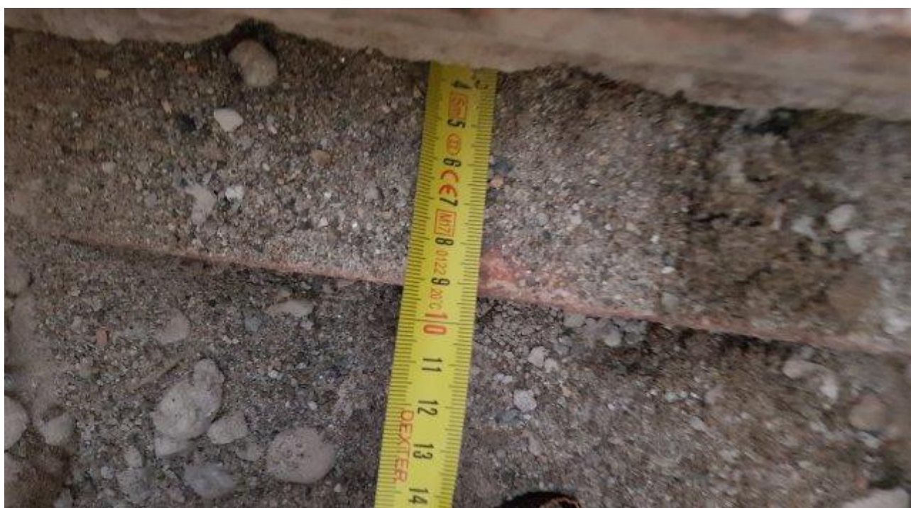
VERIFICA SPESSORE SOLAI CORPO CENTRALE (PRIMO PIANO)
