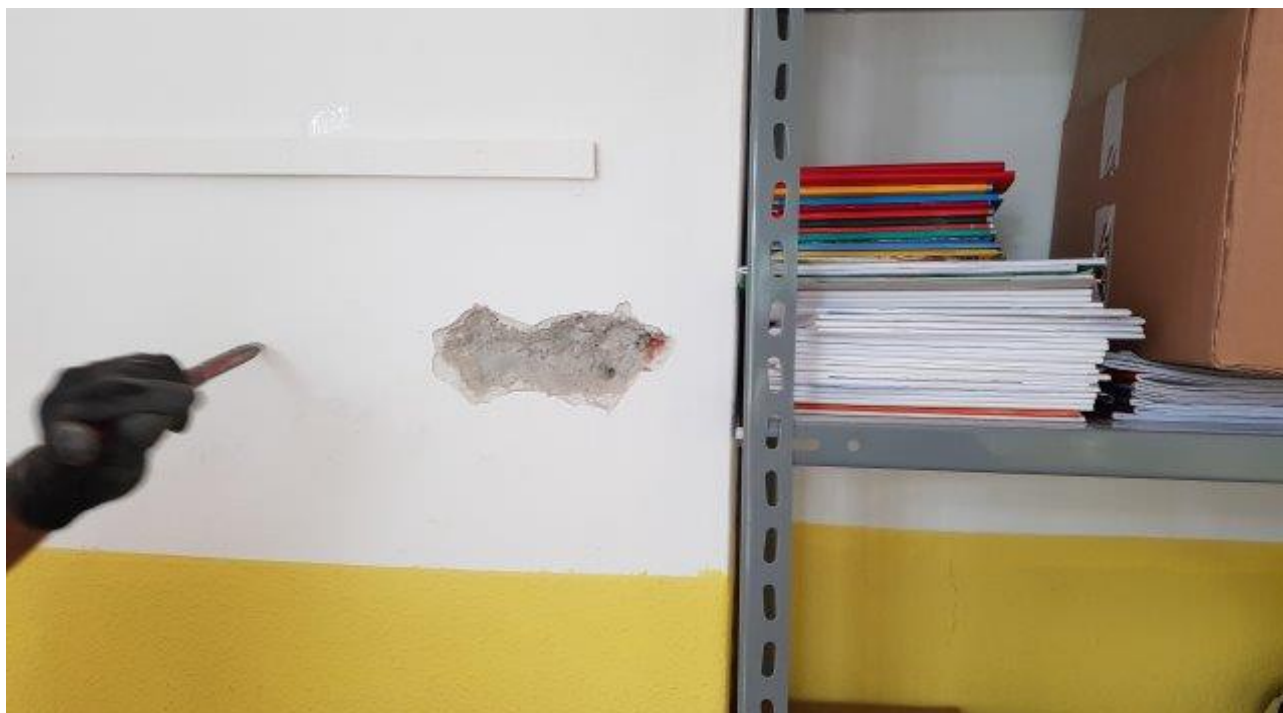
RICERCA ARMATURE PILASTRI CENTRALI EDIFICIO LATO NORD (PRIMO PIANO)
