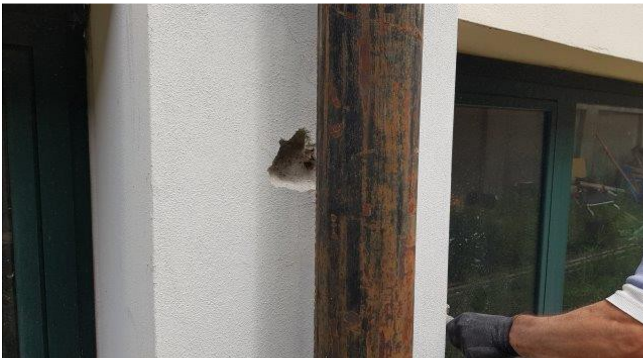
RICERCA ARMATURE PILASTRI PALESTRA (PIANO TERRA)
