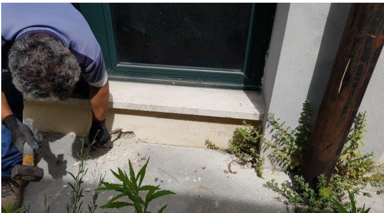
RICERCA ARMATURE MURO CONTROTERRA PALESTRA (PIANO TERRA)
