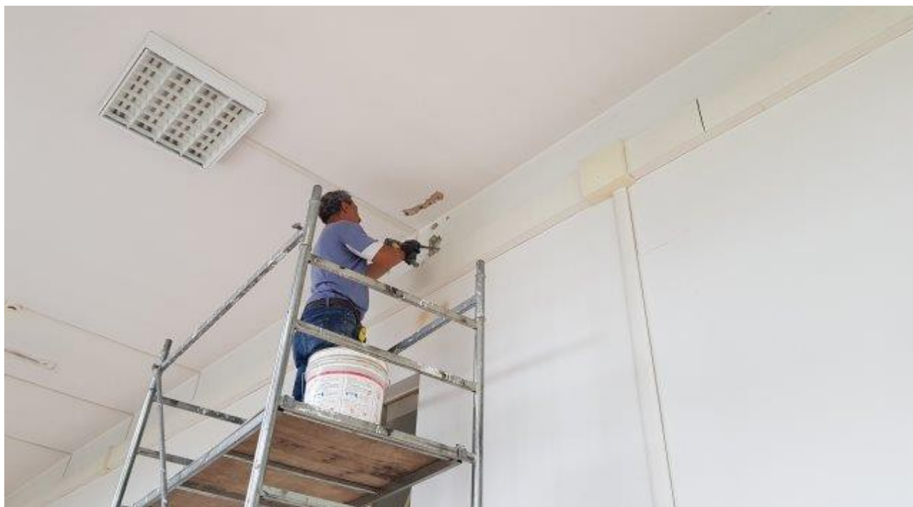
RICERCA ARMATURE TRAVI CENTRALI EDIFICIO LATO NORD (PRIMO PIANO)
